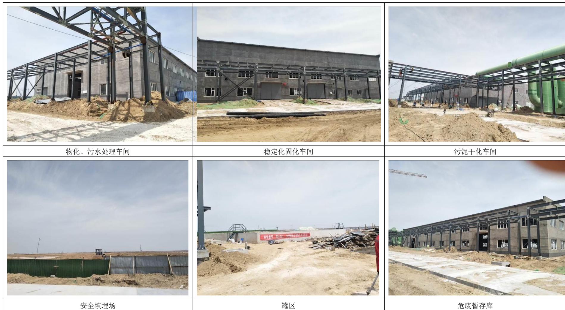
图 2-2-1 现场实际建设情况
